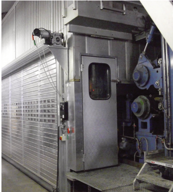
Kartonmaschine mit Wärmerückgewinnungshaube
